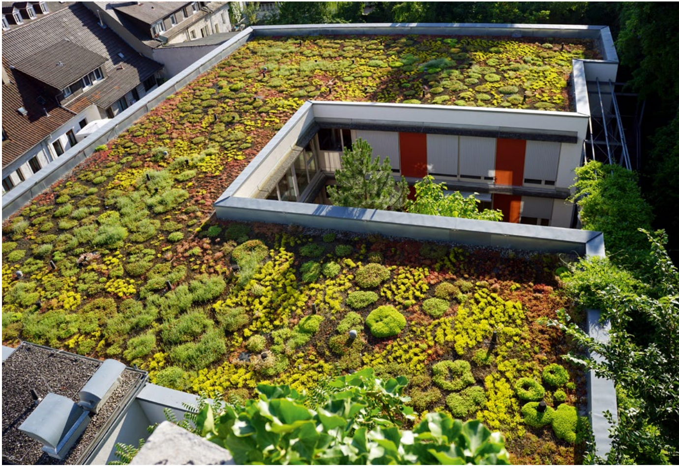
Dachbegrünung, begrünter Innenhof und Verschattungselemente an den Fenster zum Hitzeschutz im Gebäude und im Wohnumfeld.
